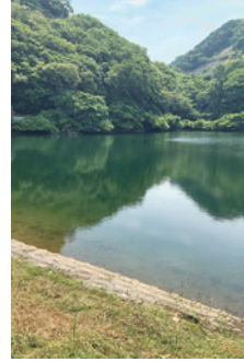
▲防災重点農業用ため池
