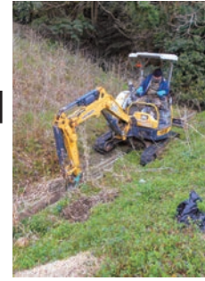
▲業者による水路の浚渫作業
