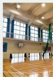
▲空調設備のない学校体育館
