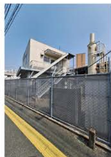
▲利活用が望まれる東部污水处理場跡地
