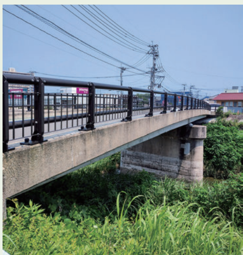
▲長寿命化対策が施された越田橋
