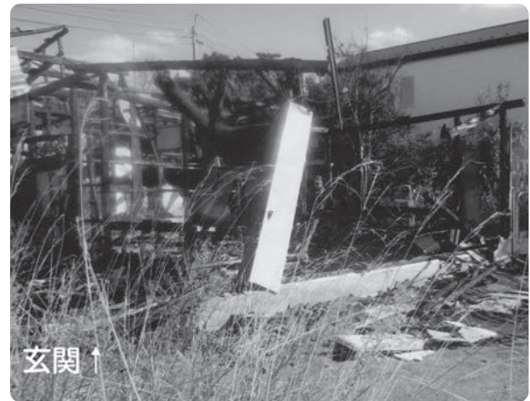
全焼した原町2区の空き家
