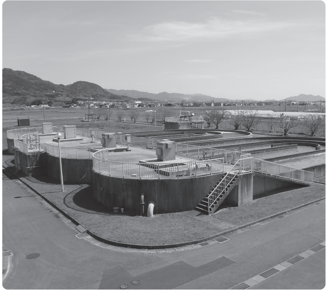
津屋崎浄化センター
