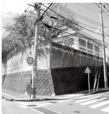
危険なブロック塀の撤去・改修
