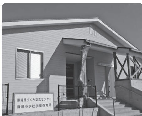
新設された勝浦小学校学童保育所
