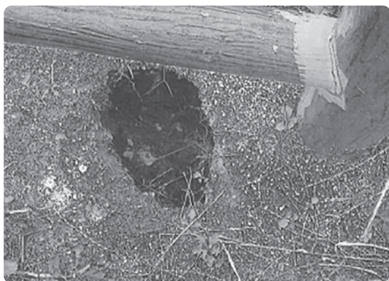
西郷川河原橋付近に大雨によりできた穴
