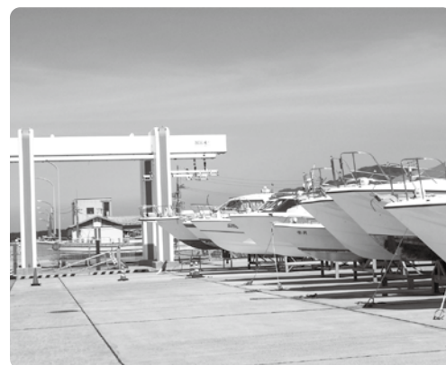
福岡漁港係留施設
