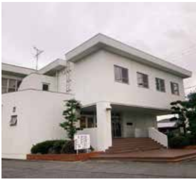
▲改修工事を行う福間体育センター
