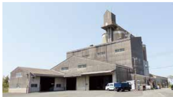
▲解体されたカントリーエレベーター
