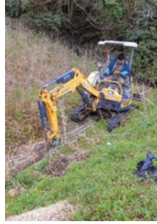
▲業者による水路の浚渫作業
