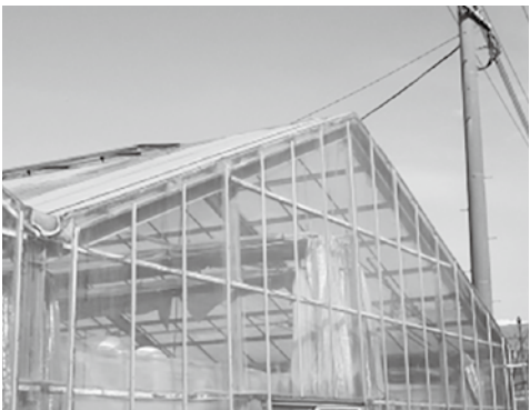
復旧済みの農業用ハウス
