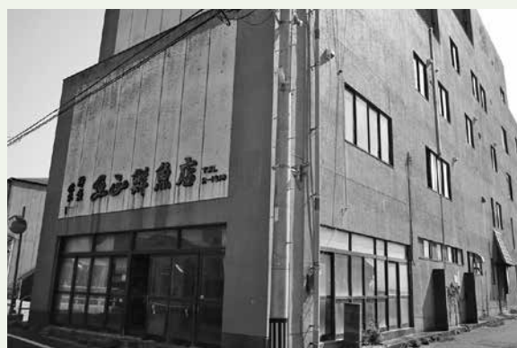
危険な状態で放置されている旧魚正ビル
