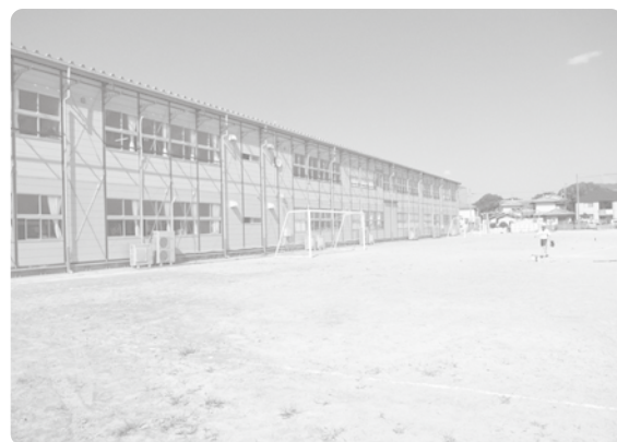
生徒数増大が問題となっている 福岡中学校建設現場
