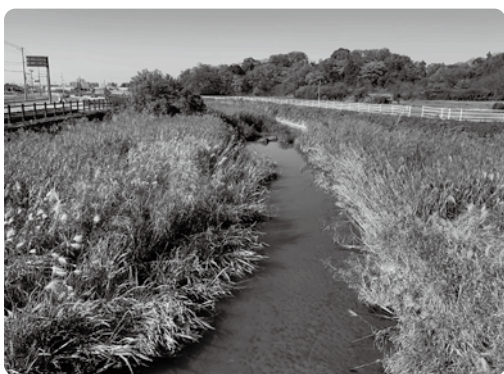
土砂など堆積物の除去(浚渫)が急がれる西郷川
