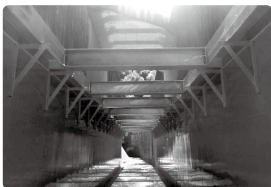
補強工事された余水路
