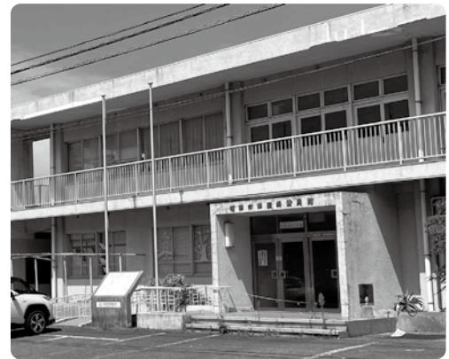
津屋崎公民館解体後の跡地利用は
