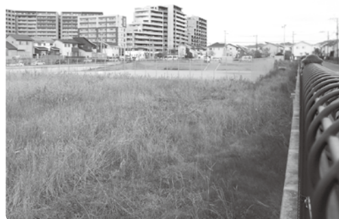
福間中学校の第2運動場として整備される 日蒔野2号調整池（日蒔野3丁目）
