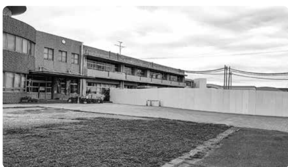
学校給食共同調理施設と教室複合棟が増築される津屋崎小学校
