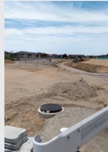
▲開校に向けて工事をすすめている新設校用地
