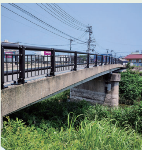
▲長寿命化対策が施された越田橋
