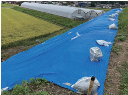
▲被災した辰ヶ鼻ため池の堤体
