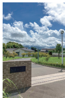
▲平成20年に整備された福岡浄化センター
