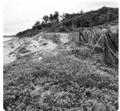
破損した竹柵と堆積した海砂
