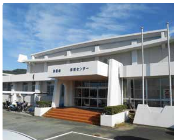
津屋崎体育センター
