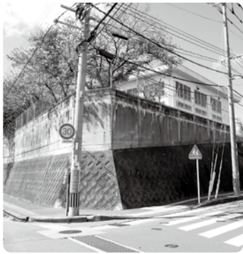
危険なブロック塀の撤去・改修
