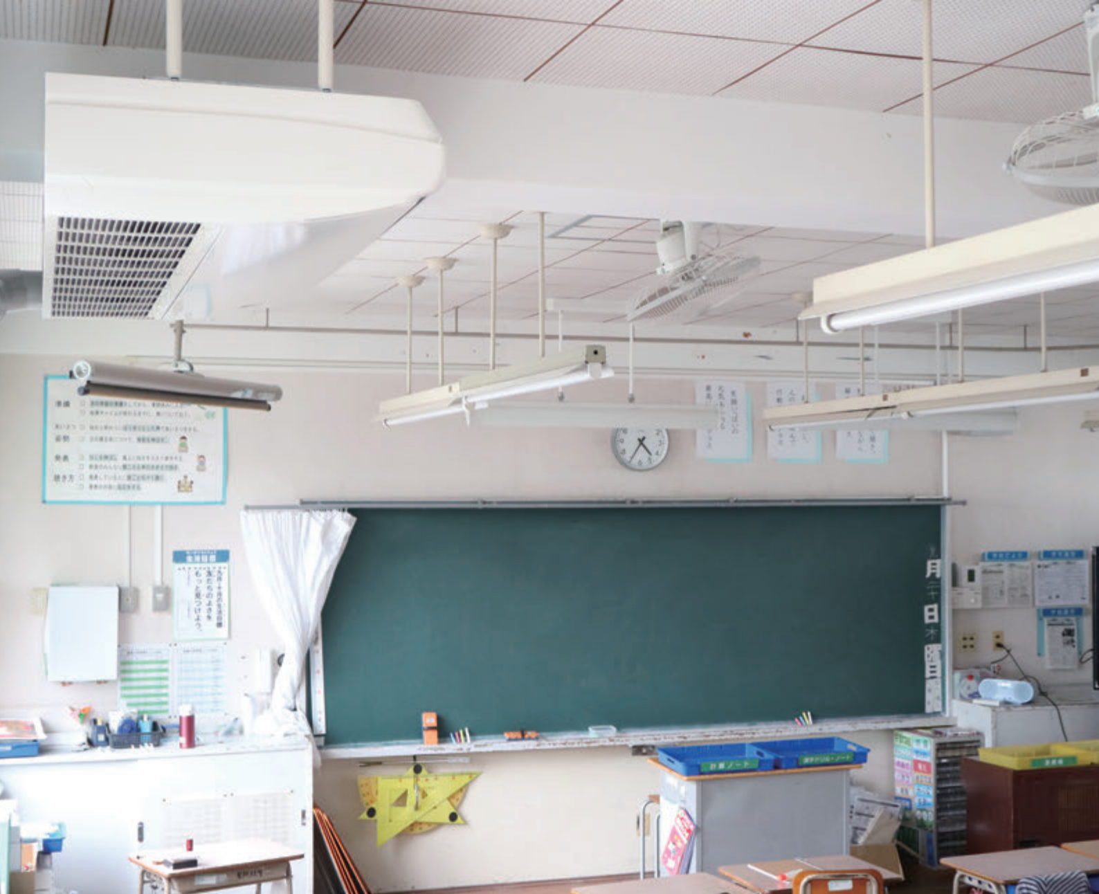
■ 福間小学校 既存教室にエアコンを設置
