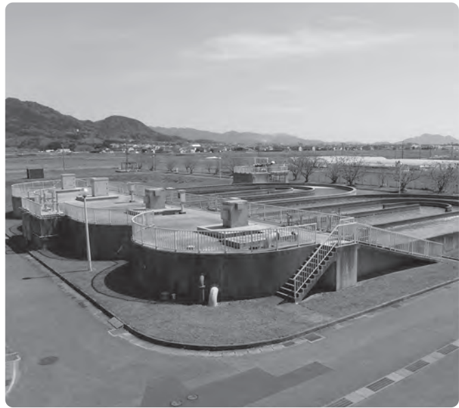
津屋崎浄化センター
