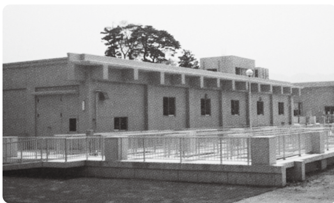
5池目を建設する福岡浄化センター
