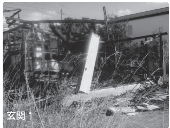
全焼した原町2区の空き家
