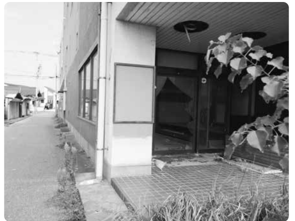
津屋崎地区にある空きビル
