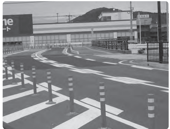
開通した道路（松原橋付近）の交通安全対策を
