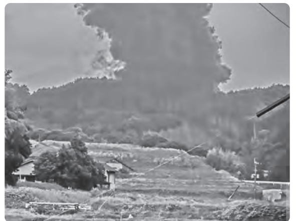
黒煙をあげ燃える産廃施設
