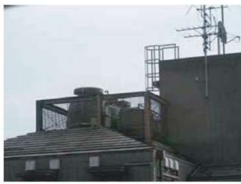
■屋上施設の周りを壁面と同系色のフェンスで覆い、目立ちにくくしている。
