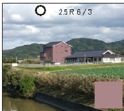
▲市内全域の例（外観）
