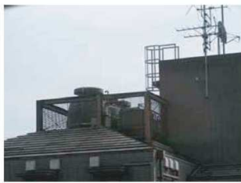
■屋上施設の周りを壁面と同系色のフェンスで覆い、目立ちにくくしている。
