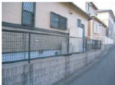
【植栽のないネットフェンス】
