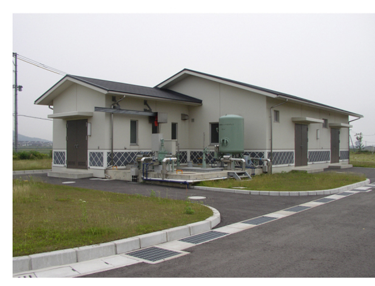
放流ポンプ棟
