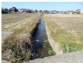
⑨敷地東側から敷地内水路を望む
