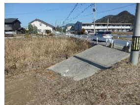
⑦敷地南側進入路
