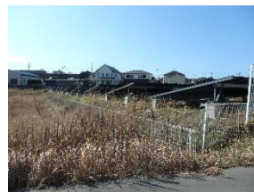
⑪東側隣地の太陽光パネル
