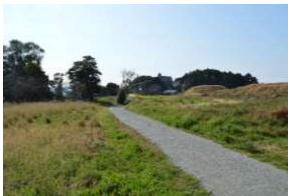
既存農道等を利用した園路（碎石舗装）
