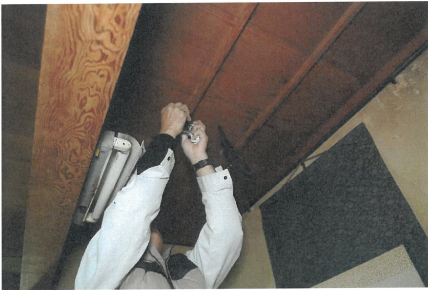
写真5 本座敷棟 床 探知機設置工事
