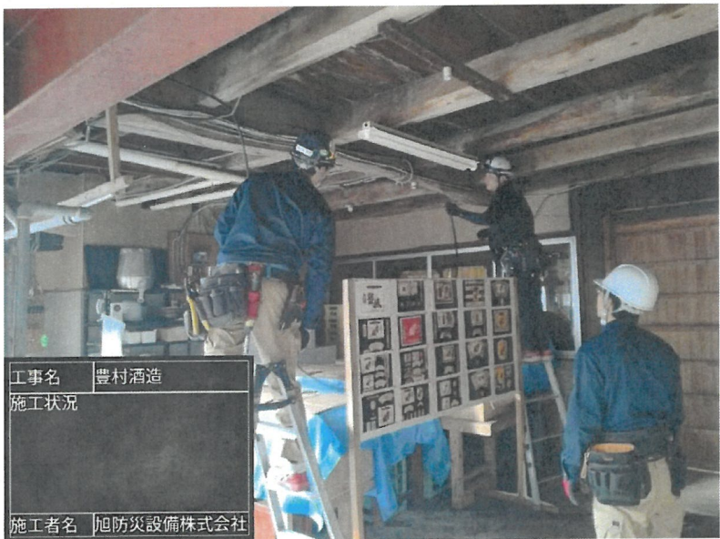
写真2 作業所 配線作業
