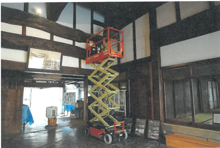
写真6 主屋 土間 高所作業車
