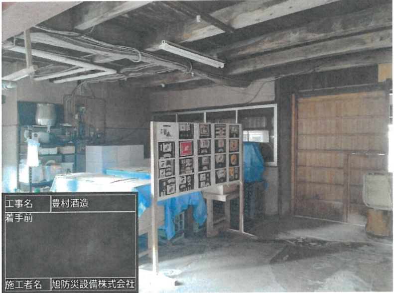
写真1 作業所 施工前
