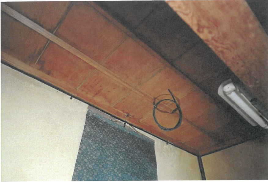
写真4 本座敷棟 床 配線済
