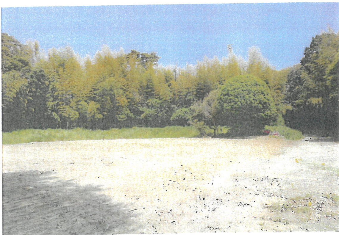
建築物等の解体撤去 令和7年完了後（南東から）
