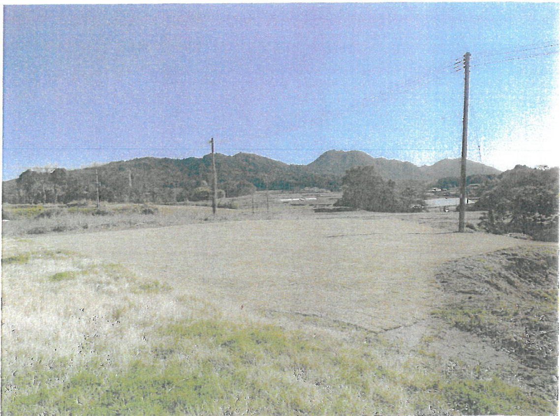
写真3 施工後（北西から撮影）
