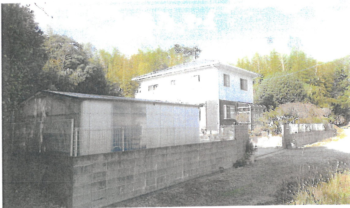
建築物等の解体撤去 令和6年着手前（南東から）
