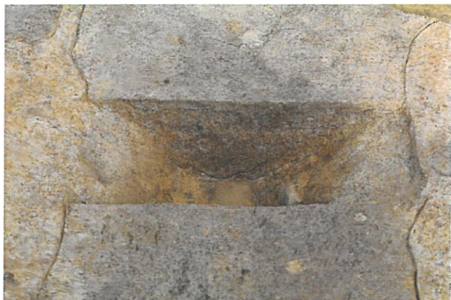
SD-02 土層（南西から）
