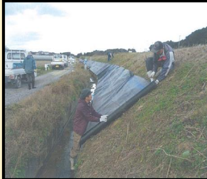
防草シートの施工
