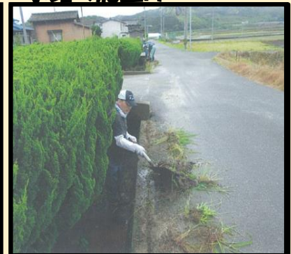
水路の泥上げ
