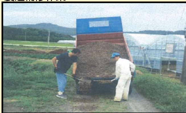
農道補修作業
