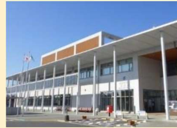
【常総市役所庁舎】
