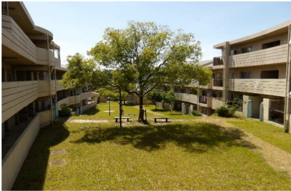
住棟(B棟、C棟)・中庭
