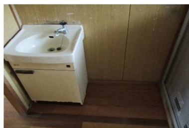
住戸内(洗面・脱衣室)
