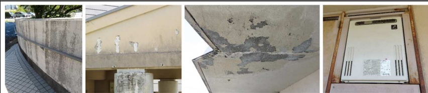
外壁・塗装の状況
