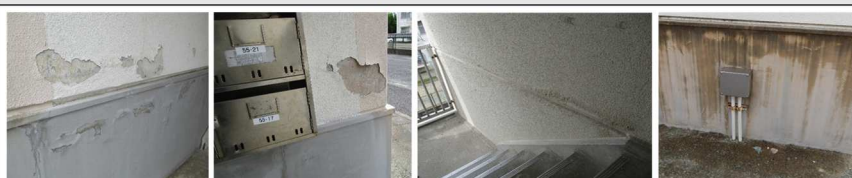
外壁・塗装の状況
