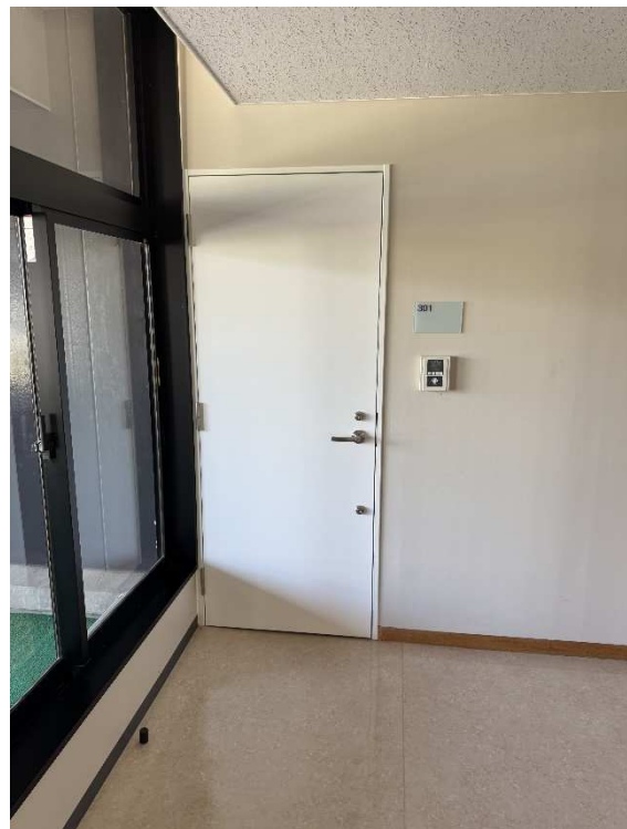
入口扉（小部屋） ※大部屋入口扉 2 か所は 2 枚扉
