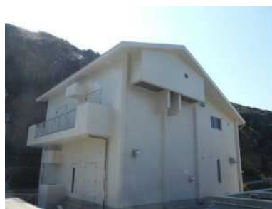
<大島簡易水道>
