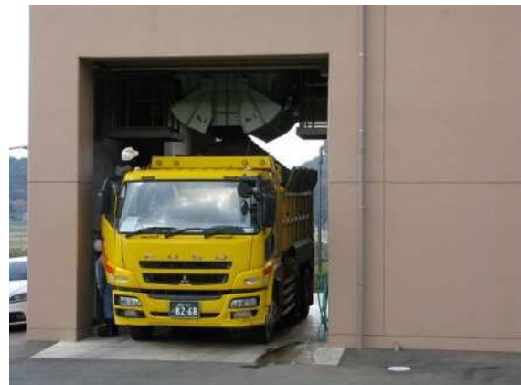
<汚泥搬出状況>
