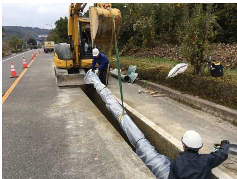
<管路の更新工事>
